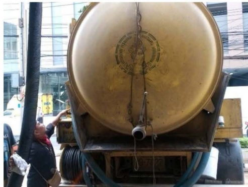
ภาพที่ 2-38 การสูบล้างทำความสะอาดจากบ่อเกรอะของระบบบำบัดน้ำเสีย
