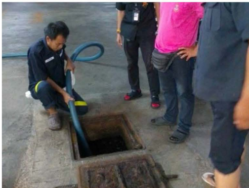
ภาพที่ 2-38 การสูบล้างทำความสะอาดจากบ่อเกรอะของระบบบำบัดน้ำเสีย
