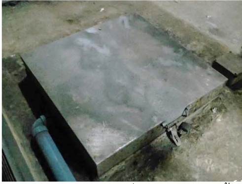
ภาพที่ 2-19 บ่อหนองน้ำใต้ดินและท่อรวบรวมน้ำบนดิน
