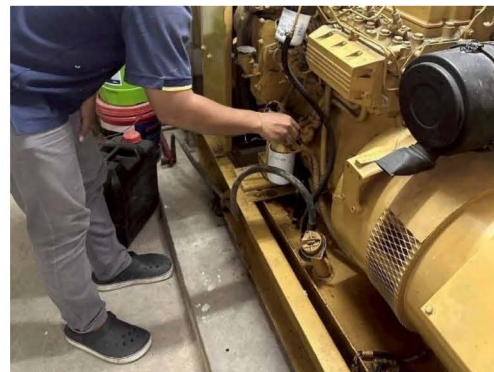
ภาพที่ 2-10 เครื่องกำเนิดไฟฟ้าสำรองในห้องเครื่องชั้นใต้ดิน
