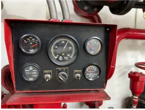
ภาพที่ 2-6 การทดสอบการทำงานของเครื่อง สูบน้ำดับเพลิง
